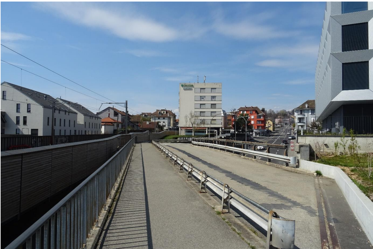
Figure 18 : vue sur le Pont de la Panchaude - @Ville de Pully
