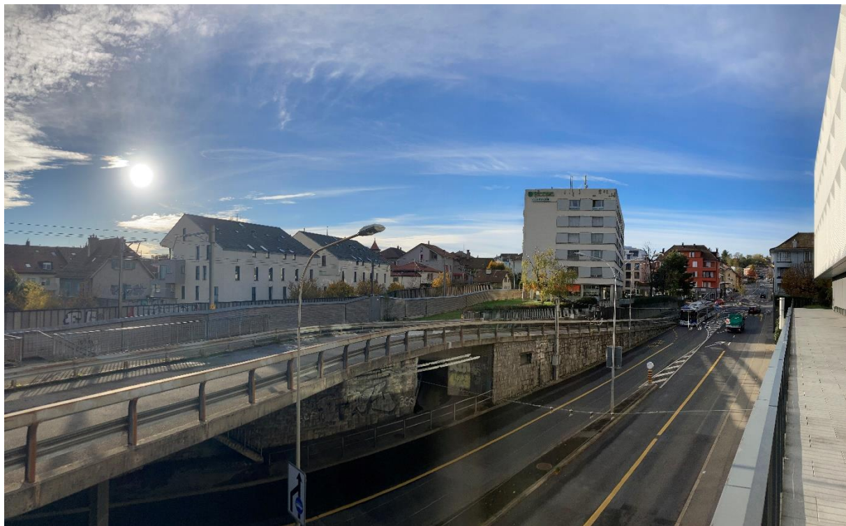
Figure 5 : vue sur la rampe et le pont de la Panchaude - @Ville de Pully
