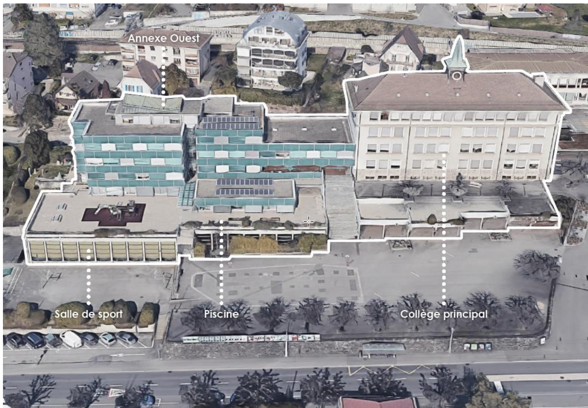
Vue aérienne des bâtiments existants
