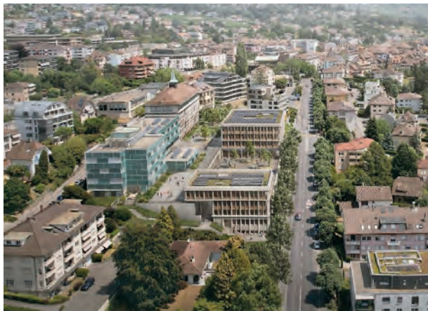
Vue aérienne en 3D du Collège Principal
