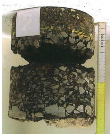
Carottage de l'enrobé
