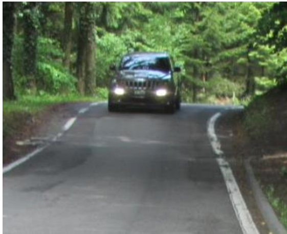
Largeur de chaussée insuffisante
